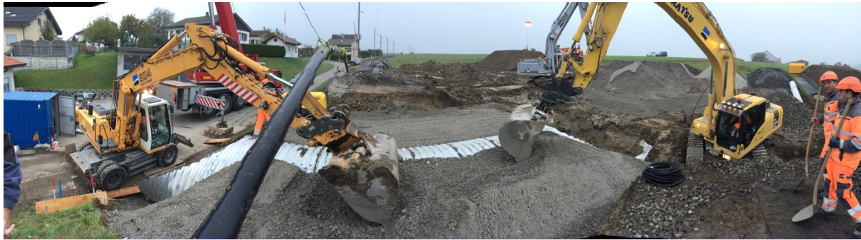
Pose de la buse de St-Protais par les TPF
