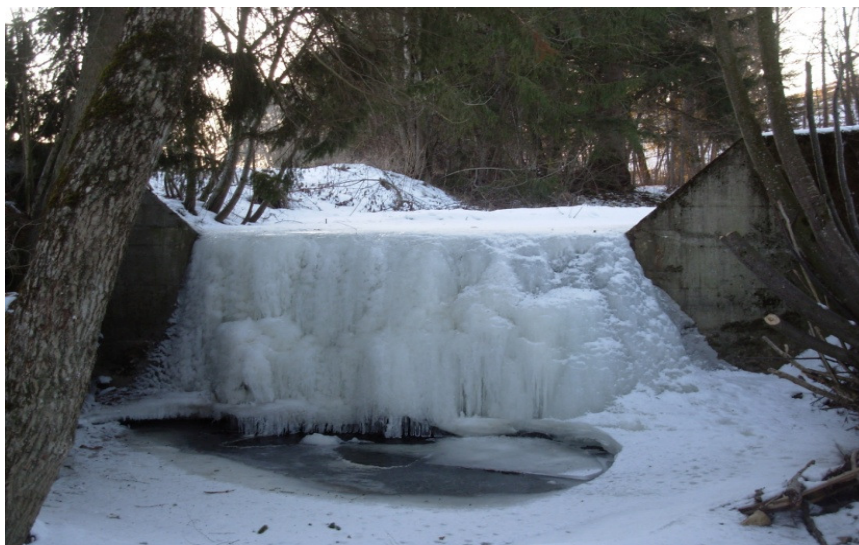
Retenue d'eau du ruisseau du Diron
